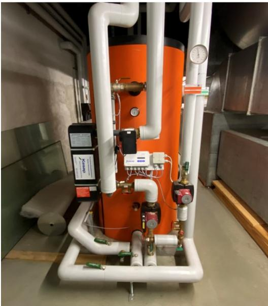
Bild: Speicherladesystem mit Puffer
