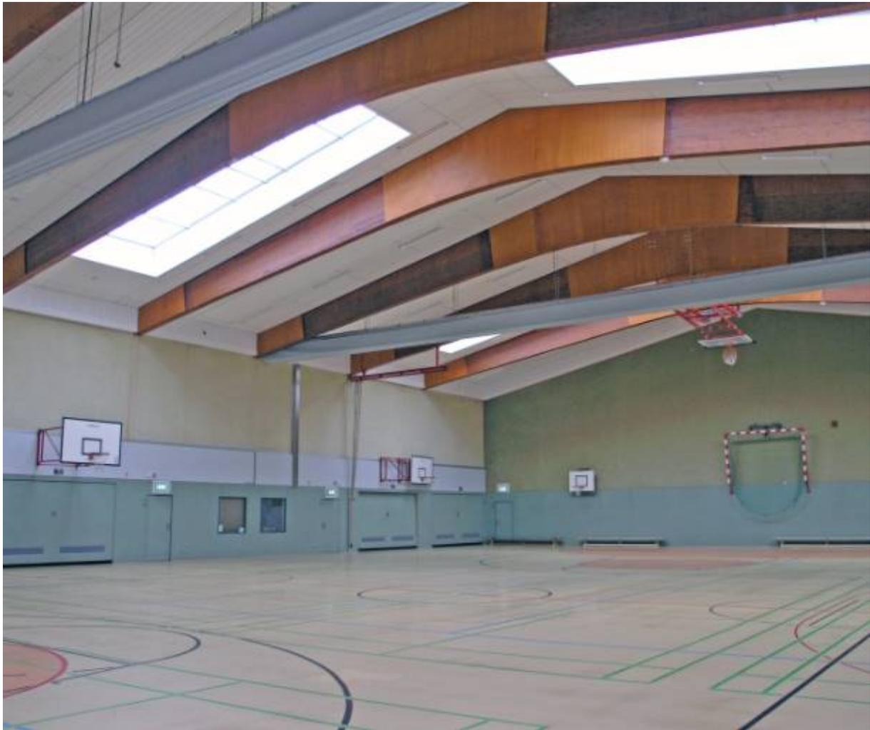
Bild: Halle mit Deckenstrahlheizung
