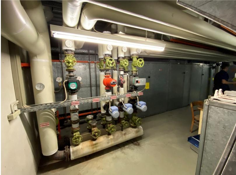
Bild: Heizungsverteilung Kreissporthalle
